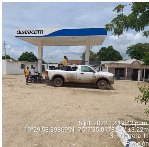
Fotografía No. 1 –Coordenadas de Ubicación EDS DISTRICOM -REPELON.
