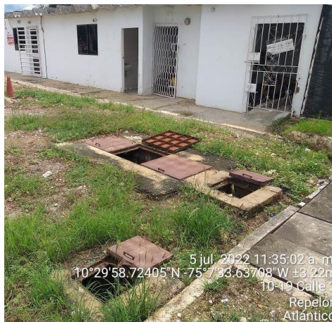
Fotografía No. 2 – Sistema de tratamiento primario CON DOS (2) cámaras de sedimentación.
